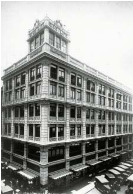
High-Life. Le nouvel édifice dans sa version de 1924, où travaillera Robert Fischer, l'oncle d'Alain et de Gérard Wertheimer.
